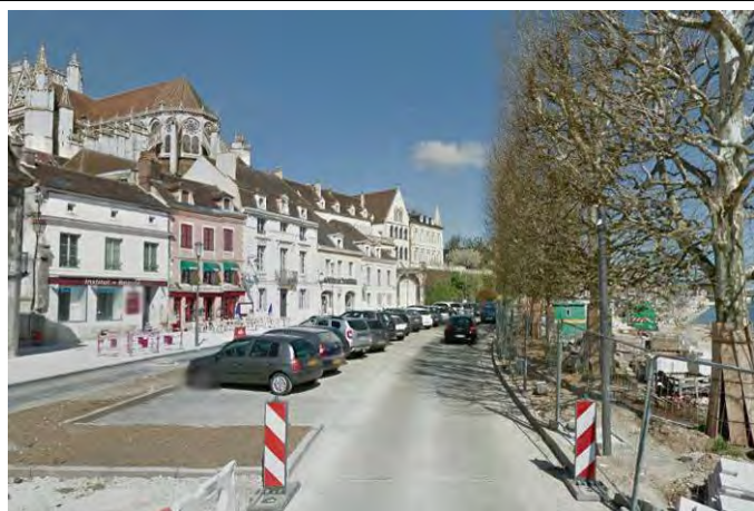
Habitations groupées secteur Nord
