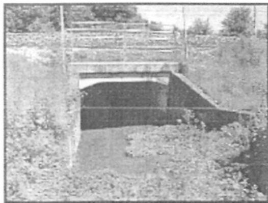
Aval OH 16 : Voie de Chemin de fer
