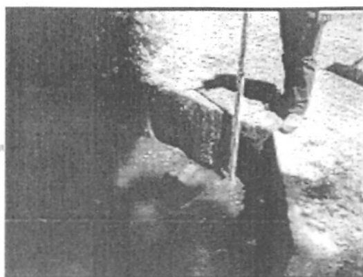
Aval OH 10 : bourg Station d'épuration
