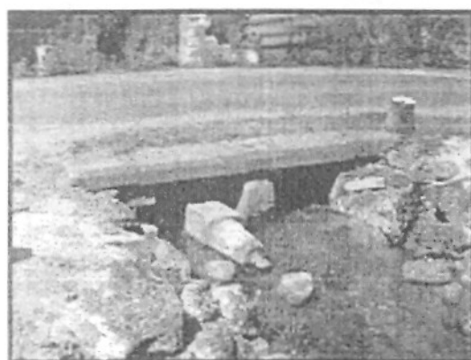
Amont OH 7 : bourg Rue du Pont de Pierres
