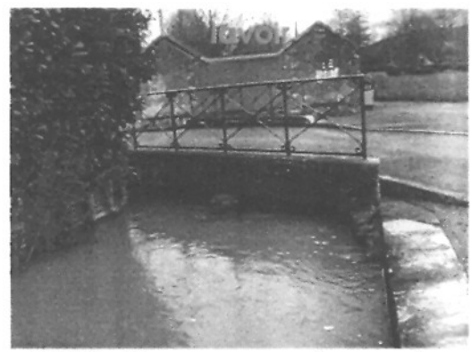
OH5' - Passage sous la rue des Buttes en direction du lavoir
