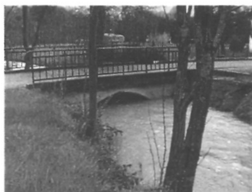
OH9 - Passage sous la rue de l'Amandier
