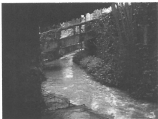
Vue vers l'aval depuis le lavoir
