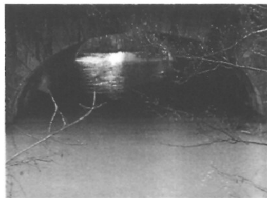
OH4' - Passage sous la voie ferrée
