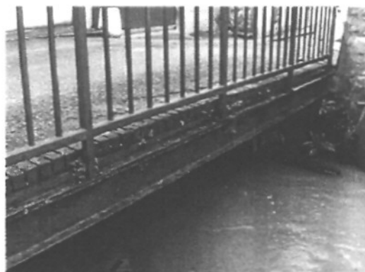
OH6' - Passage sous la rue du Moulin d'en Haut
