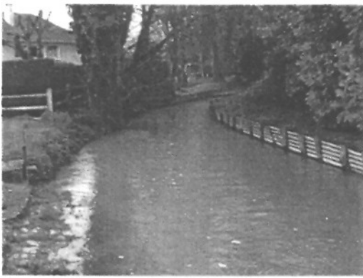
Vue à l'amont du carrefour entre les rues des Buttes, de la Vanne et du 6 Juin 1944
