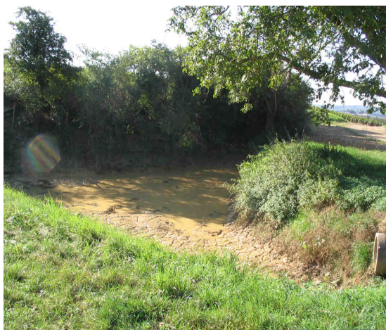
Bassin de rétention en partie envasé dans le secteur de « La côte aux Juifs »
