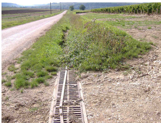
Exemple de grille pour protéger la route des ruissellements issus des vignes
