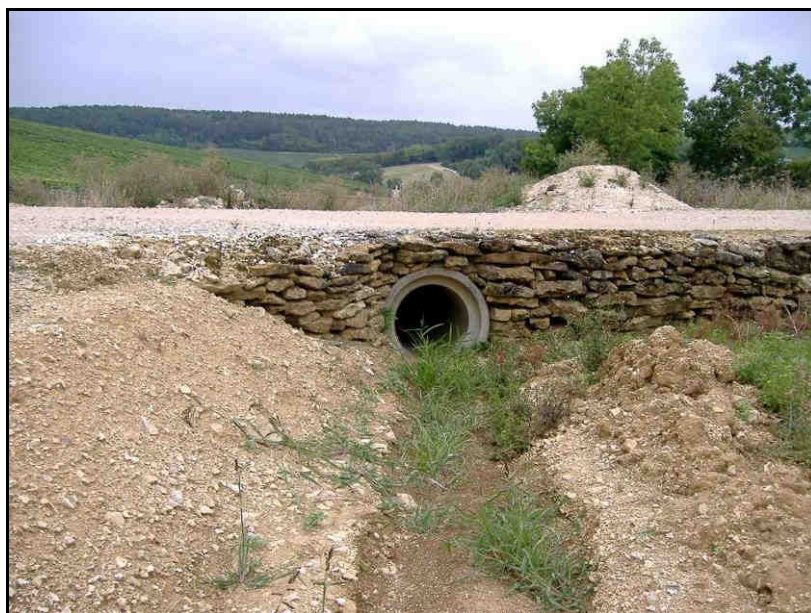
Photo 3 : exutoire de type fossé busé, à Beine
