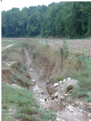
Fossé fortement érodé (82)
