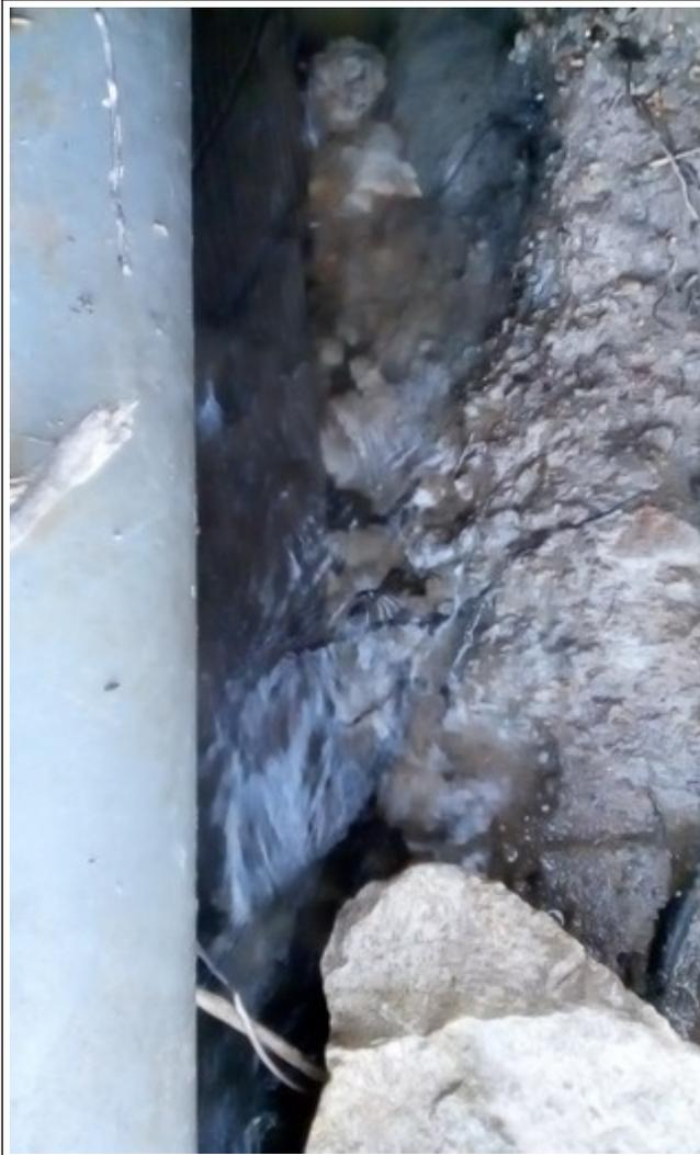
Présence d'un renard hydraulique le long du tuyau PVC constituant la prise d'eau.
