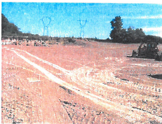
Partie exploitée et remblayée
