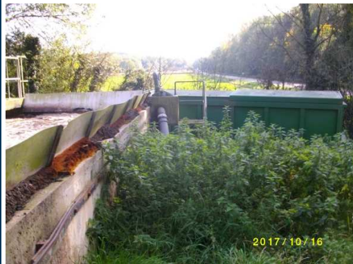
Photo 5. Cerclage du génie civil – Bassin d'aération
