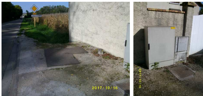
Photo 2. Poste général du Pont Rouge
