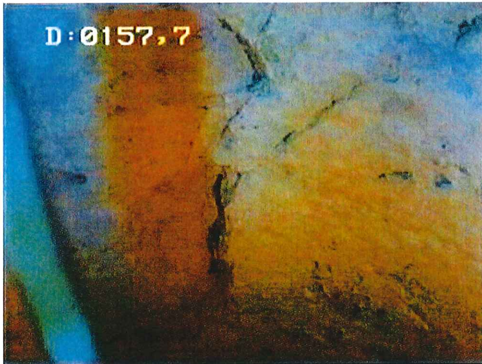
41- Trou nu – formation carbonatée massive, fracturation
