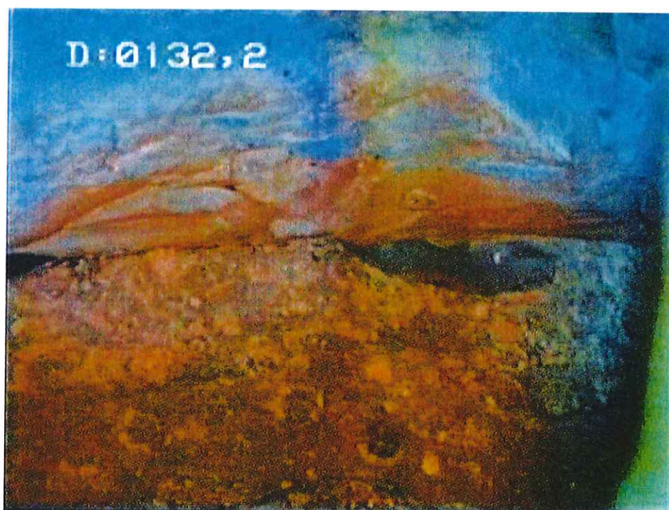
16- Trou nu – contact ciment/formation carbonatée aquifère
