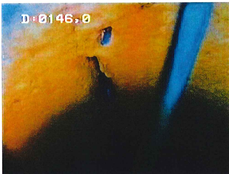
29- Trou nu – formation carbonatée massive, fracturation
