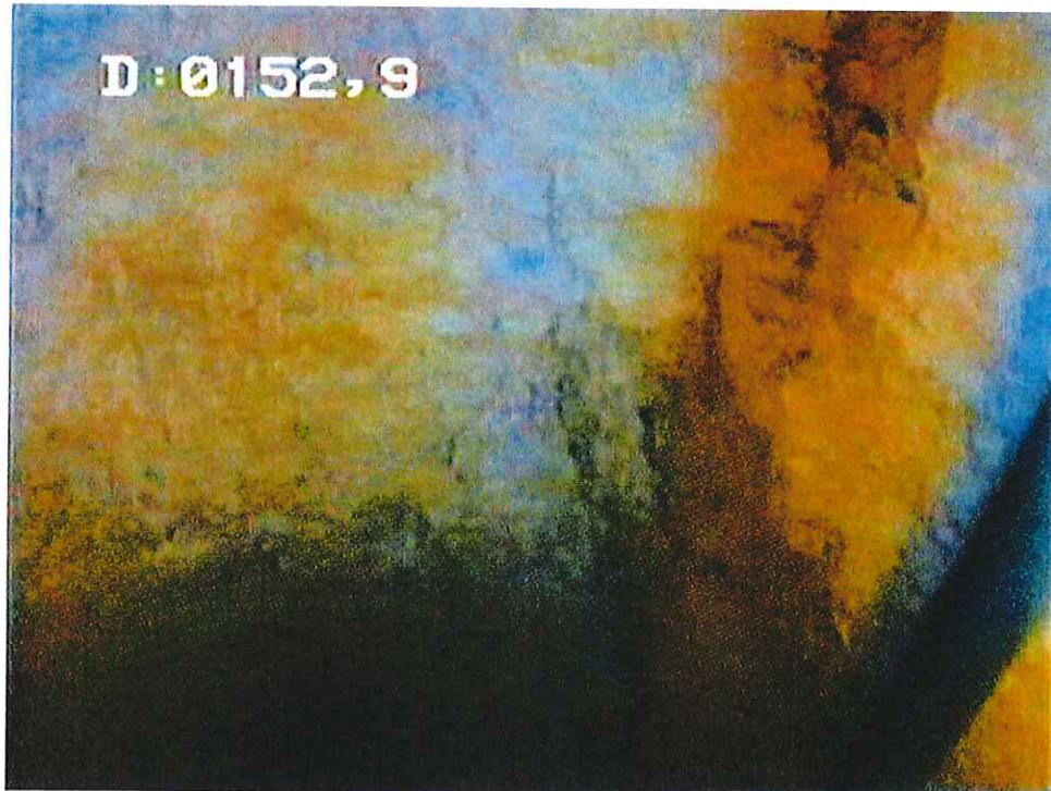
36- Trou nu – formation carbonatée massive, fracturation
