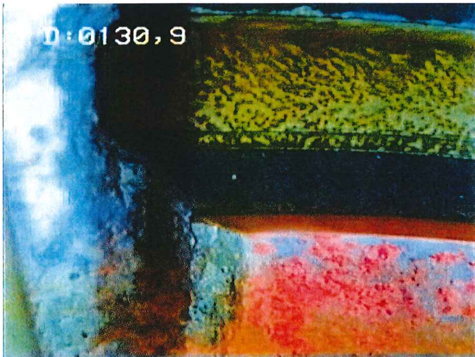
14- Tubage acier plein – base du sabot, ciment
