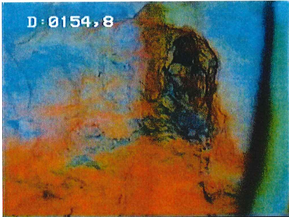
37- Trou nu – formation carbonatée massive, fracturation
