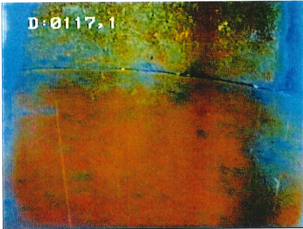
9- Tubage acier plein – légers dépôts et soudure inter-tubes
