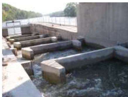
Certains ouvrages (barrages) empêchent la libre circulation des poissons (ou des sédiments). Les passes à poissons sont adaptés pour permettre le franchissement de l'obstacle.
