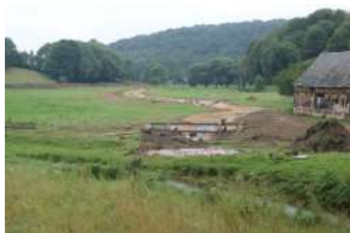
La Fontanelle en Seine-Maritime a été remise en fond de vallée afin qu'elle retrouve sa pente naturelle et qu'en cas de crue l'eau gagne des zones herbagères et des marais
